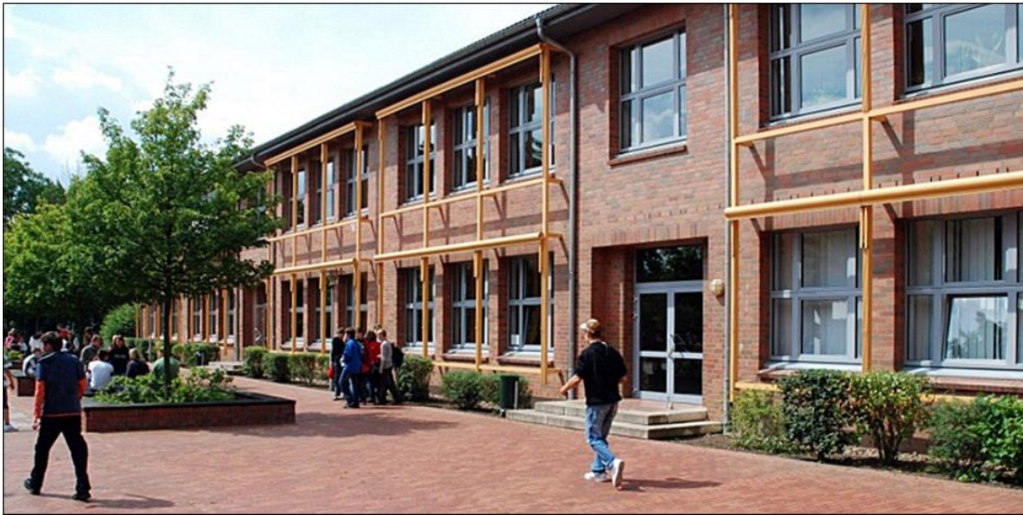
Börde-Gymnasium in Wanzleben
