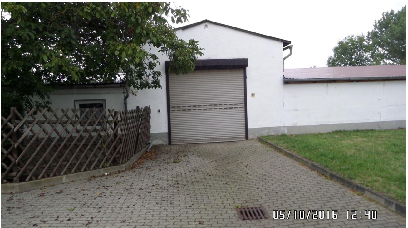
Garagengebäude mit Büroräumen (Ansicht von der Zufahrt)
