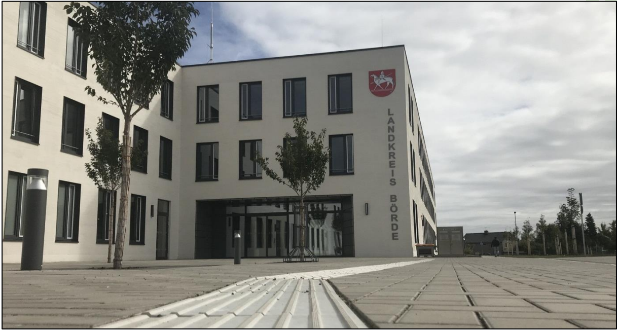
Taktils Leitsystem für blinde und sehbehinderte Menschen am Landratsamt in Haldensleben
