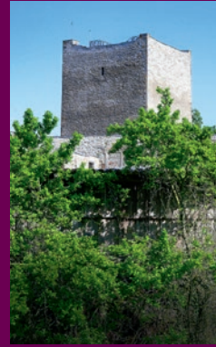
Die Burgruine Weferlingen – eine einstmals stolze Wasserburg
