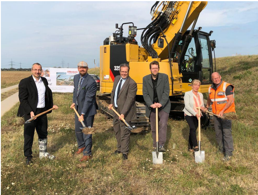
Spatenstich für den dritten und damit letzten Bauabschnitt am linken Elbedeich im Landkreis Börde (Foto Landkreis Börde)
