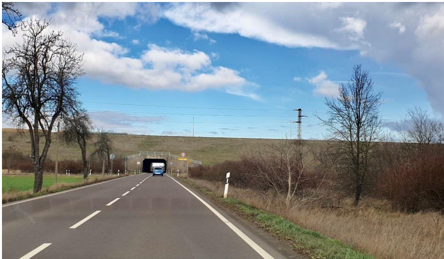
Hier ein Blick auf den Tunnel (Foto Landkreis Börde)
