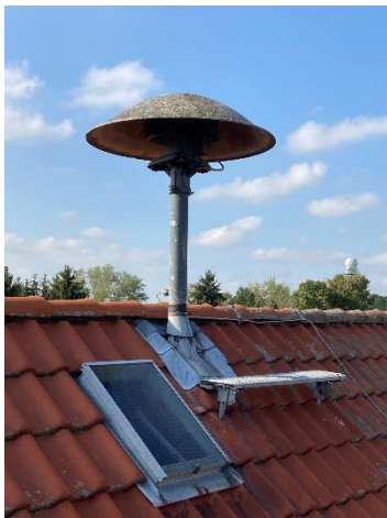
Motorsirene auf einem Dach in Ummendorf Foto Landkreis Börde
