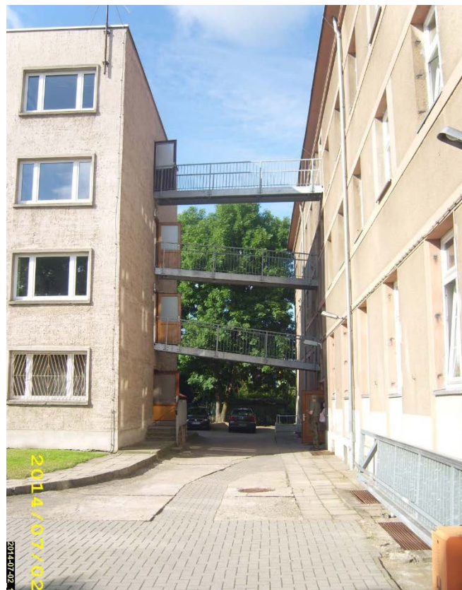
Abbildung 2 Übergang von Haus 1 zu Haus 2
